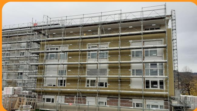
Des complexités liées à la dépose en façade de l'ancien matériau isolant ont provoqué du retard dans le planning de l'opération. De même, des difficultés dans l'approvisionnement et la fourniture des menuiseries extérieures ont perturbé l'avancement du chantier. Fin prévisionnelle de ce chantier : fin d'année 2023
